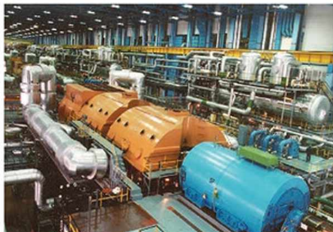
258.2. A Paksi Atomerőmű egyik generátora és a meghajtó-rendszer
